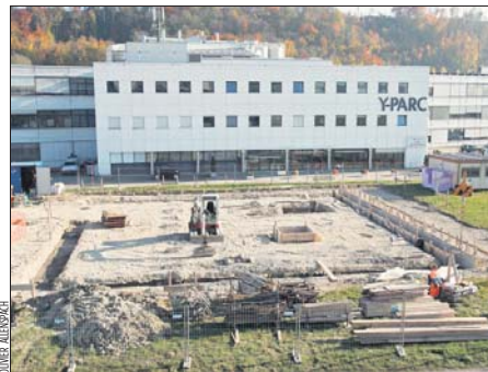
Le premier coup de pioche a été donné au futur Centre d'entreprise et d'innovation 2.
