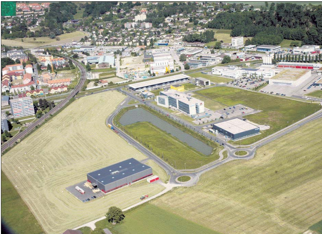
LE SITE Le Parc scientifique et technologique d'Yverdon-les-Bains compte aujourd'hui 105 entreprises et 1130 collaborateurs. Et son expansion continue. Y-PARC, ÉTÉ 2006
